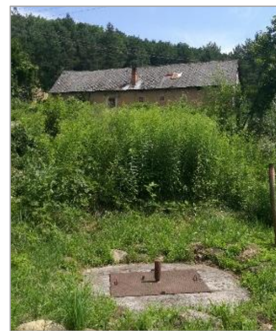
Studňa úžitkovej vody hĺbky 12 m
