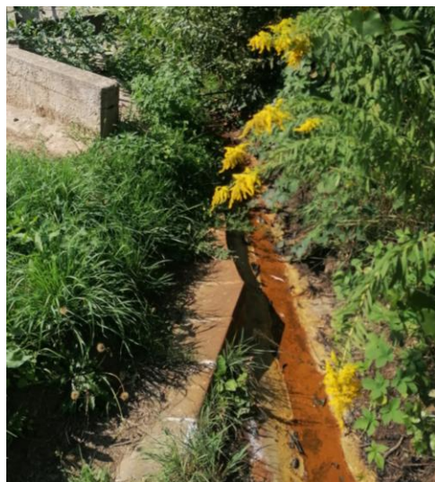
Vtok drenážnej šachty do potoka
